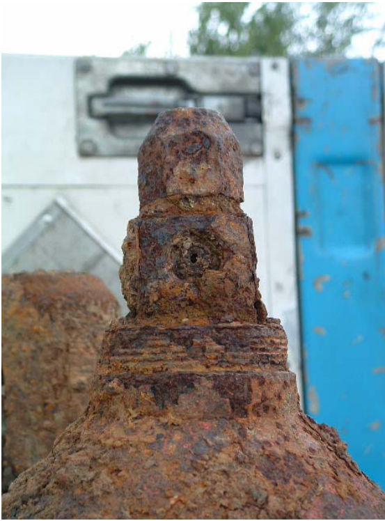
Beispiel einer stark korrodierten Azetylen-Gasflasche.
